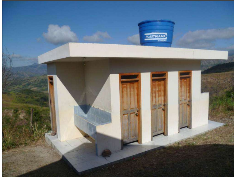
Fotografía 2.7 Se Observa La Batería Sanitaria De La Escuela "Ciudad De Madrid" Barrio San Roque
