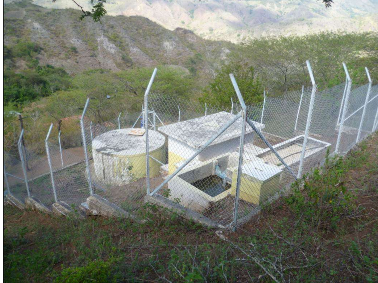
Fotografía 2.8 Vista de la Planta de AA. PP. del Barrio Tungani
