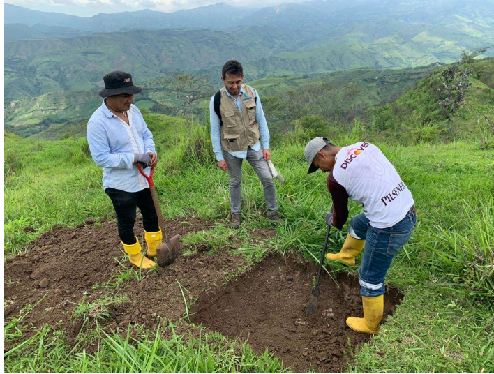
Fotografía 5.4 Calicatas en la planta de tratamiento
