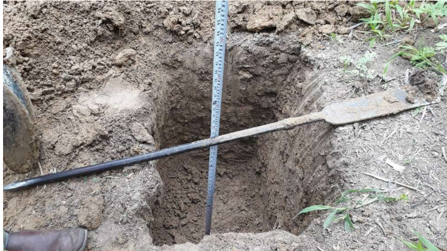
Fotografía 5.3 Calicatas en la línea de conducción
