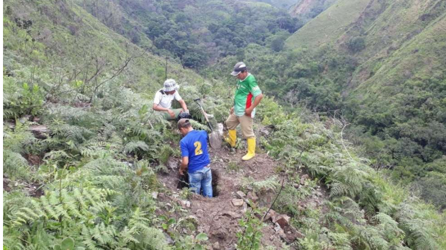
Fotografía 5.2 Calicatas en la línea de conducción
