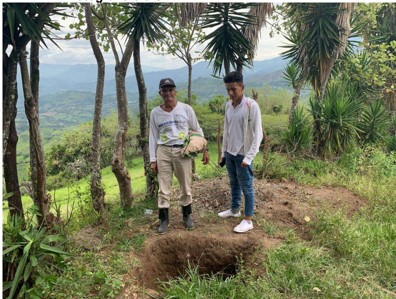
Fotografía 5.6 Calicata en la red de distribución
