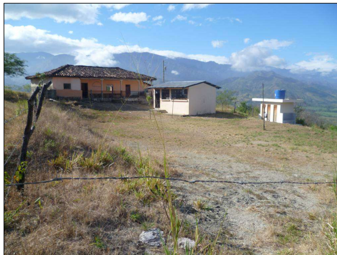
Fotografía 2.6 Vista General De La Escuela "Ciudad De Madrid" Del Barrio San Roque
