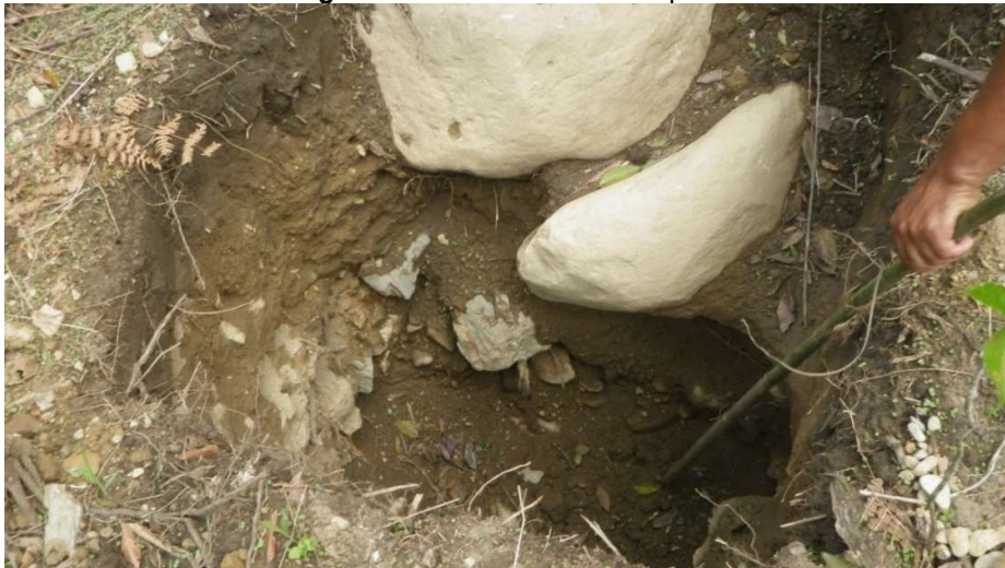
Fotografía 5.11 Calicata en la Captación
