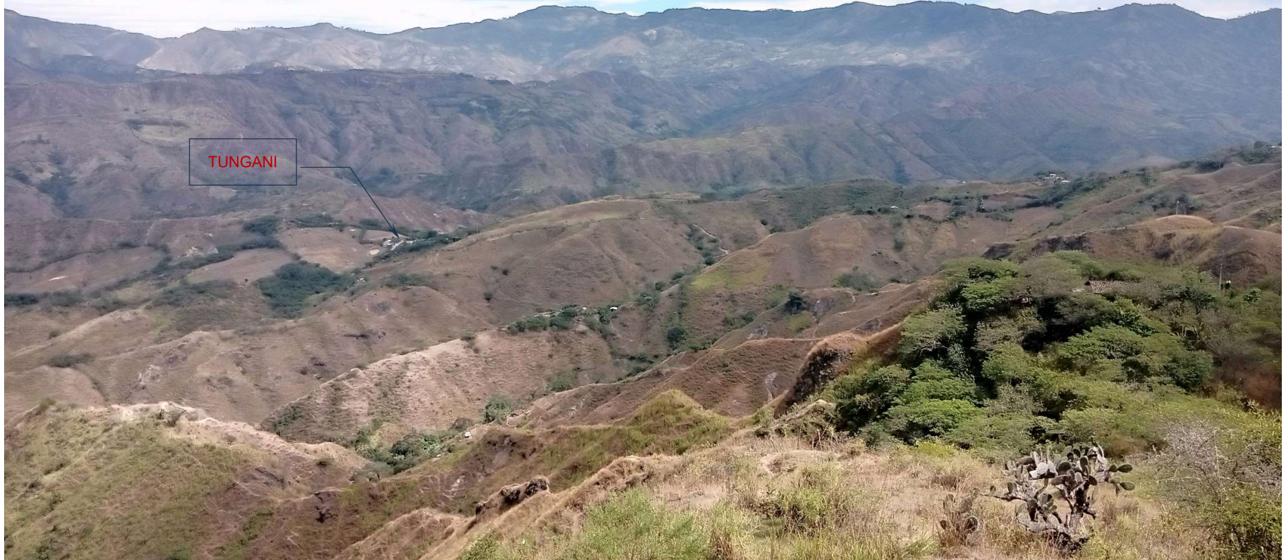
Fotografía 6.5 Vista General de la topografía del terreno por donde cruza la línea de distribución (vista desde la planta de tratamiento)
